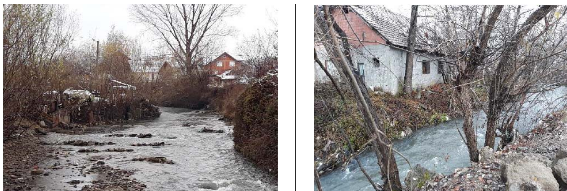
Slika 3: Suženje korita usled izgradnje u koritu reke
