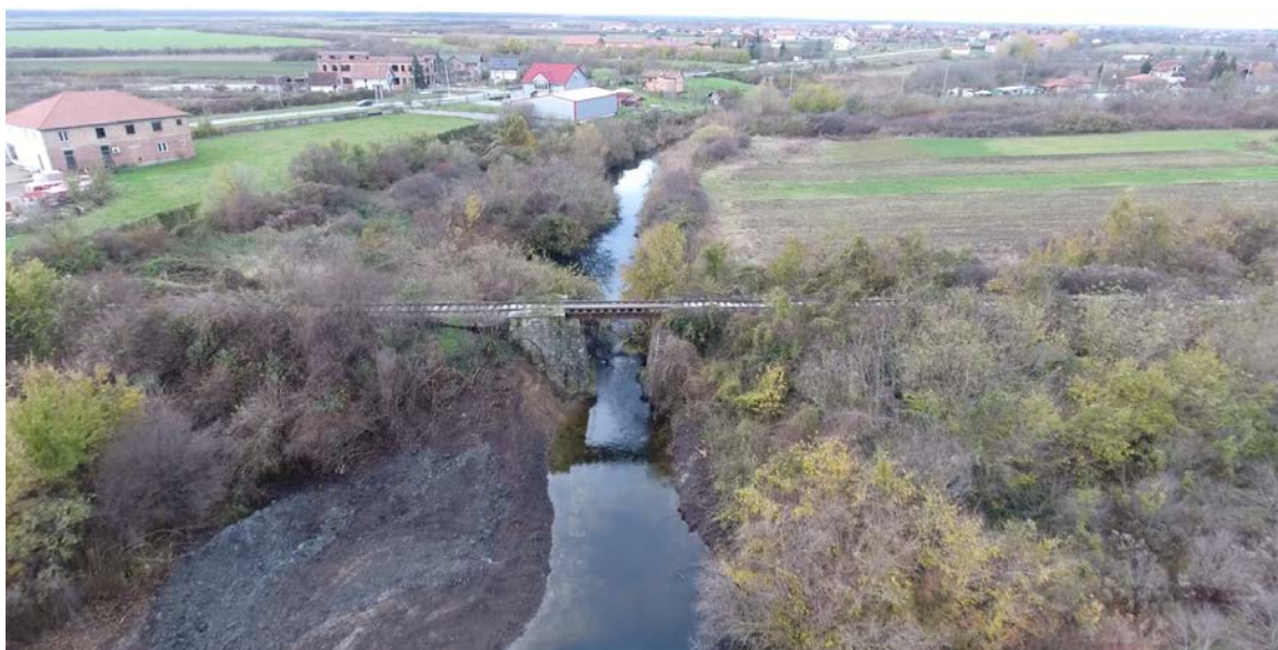
Слика 11: Железнички мост преко канала Галовица на km 10+508
