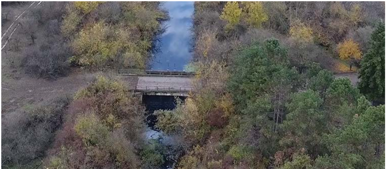
Слика 4: Мост и радијална капија на km 20+181
