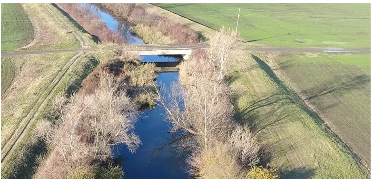
Слика 6: Мост на km 35+958
